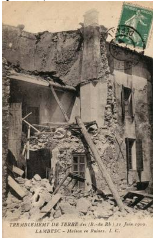
Maison en ruine à Lambesc suite au séisme de 1909 – Collection Guy JACQUET
