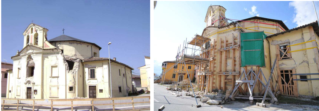
Photo avant et après sécurisation d'un édifice à Paganica (crédit photo : Michel Jourdan et Guy Jacquet)
