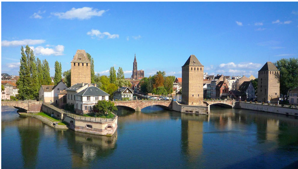
Ponts couverts de Strasbourg
